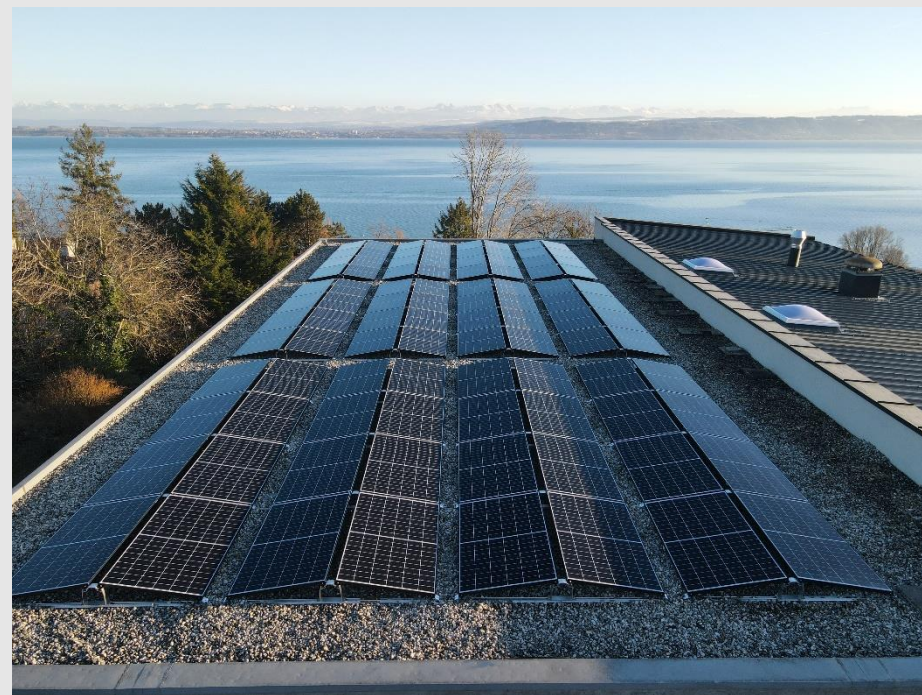
Installation toit plat de 96 panneaux de 375 Wc
