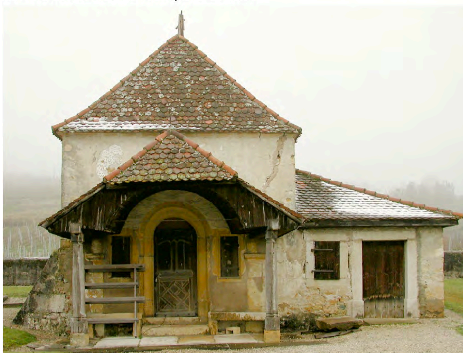
Façade sud de la chapelle en 2003.
