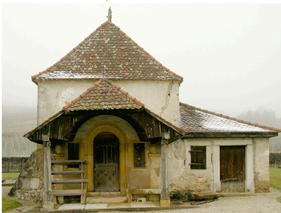
Façade sud de la chapelle en 2003.
