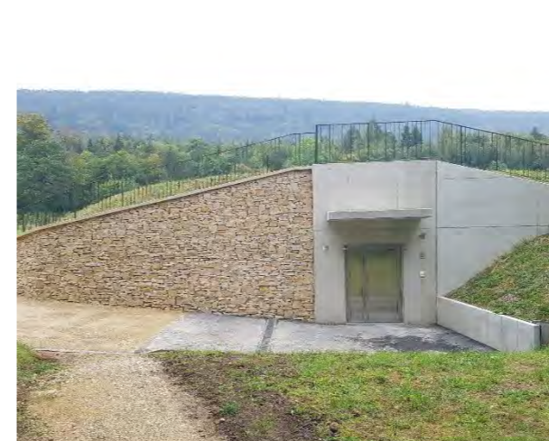
Station de pompage de Fontaine-André
