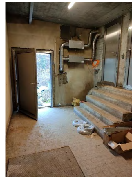
Réservoir des Aigudeurs
