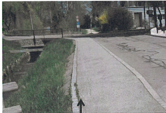
Faiçonnage du revêtement bitumineux du trottoir
