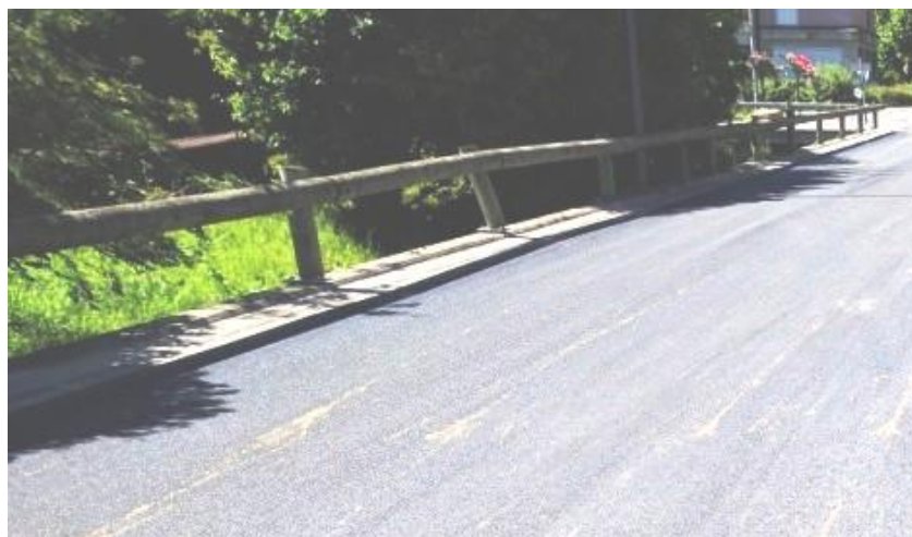
Rue du Jolimont : glissière bois-métal
