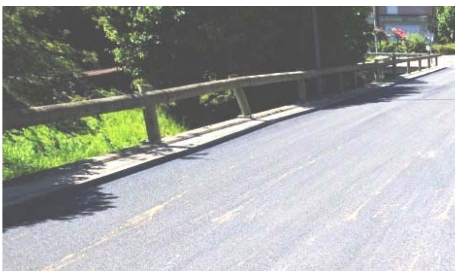
Rue du Jolimont : glissière bois-métal
